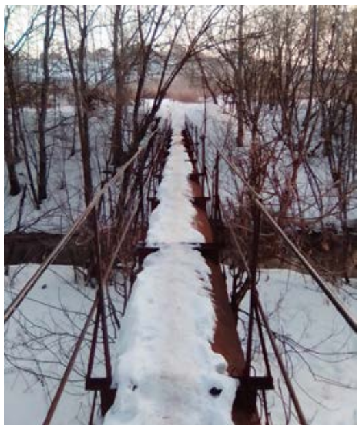
Рисунок 4. «Мост» через Старку на маршруте 2: канализационная труба
